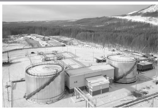
На территории горно-металлургического комбината «Удокан» завершилось строительство ещё одного важного объекта — водозабора на 10 тыс. м<sup>3</sup>/сутки на Ингамакитском месторождении подземных вод, а также водопроводных сооружений. Объект станет источником водоснабжения для обогатительной фабрики, вахтового посёлка, котельной, сервисного центра и административно-бытового комплекса. Вода соответствует гигиеническим требованиям к качеству централизованных систем питьевого водоснабжения.
